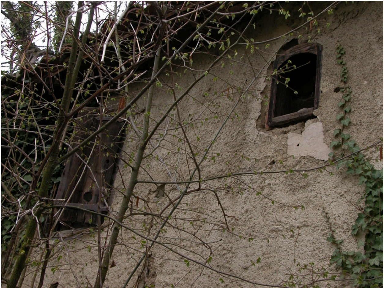
Détail de la niche en façade.
