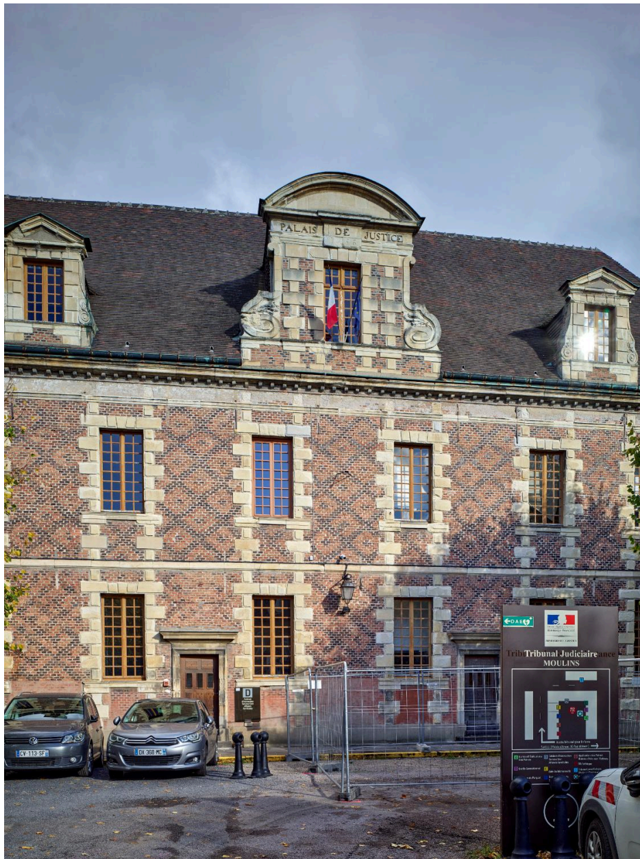
Elévation principale, vue partielle
