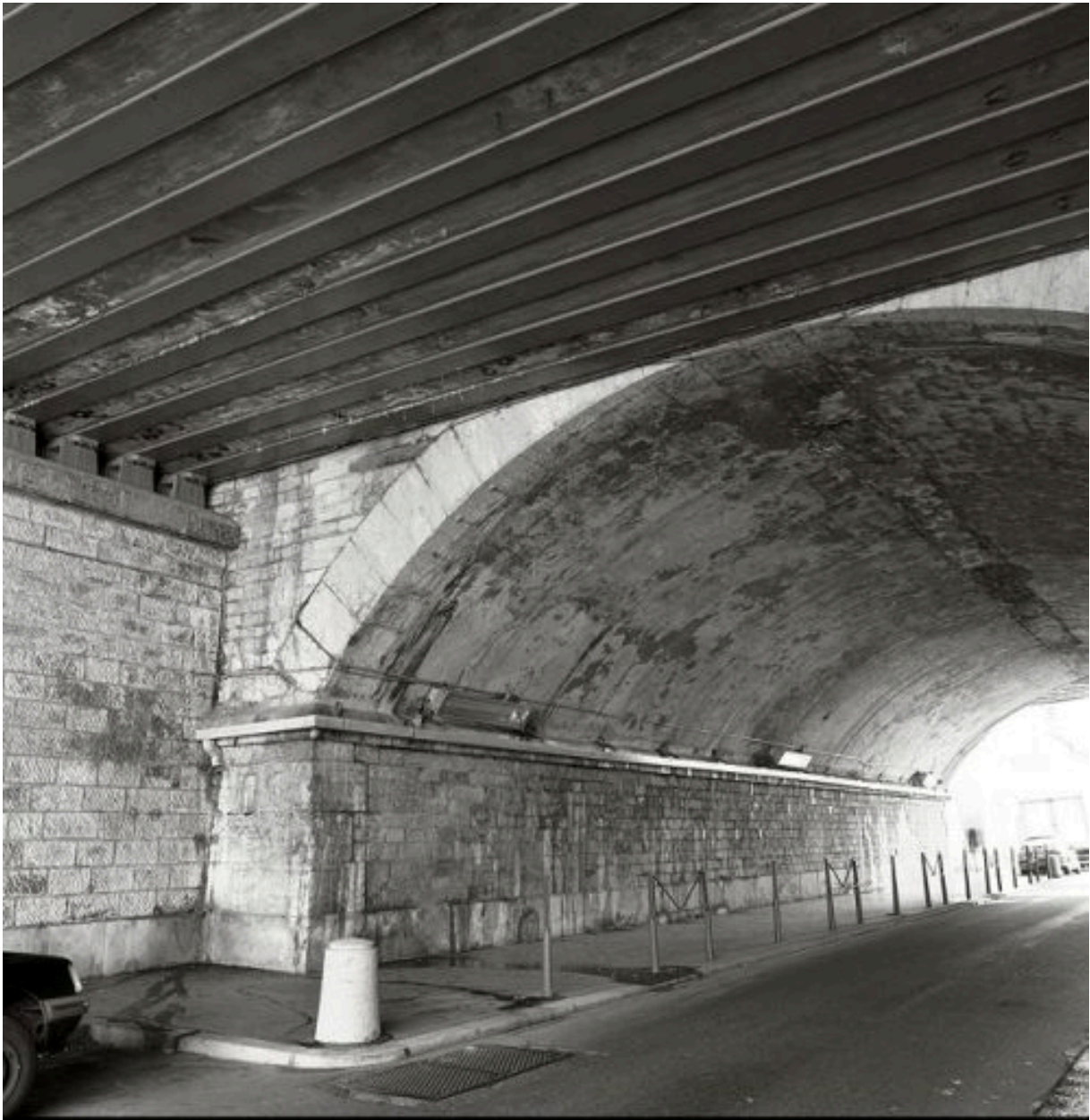
La jonction du tablier métallique et de l'arche en pierre
