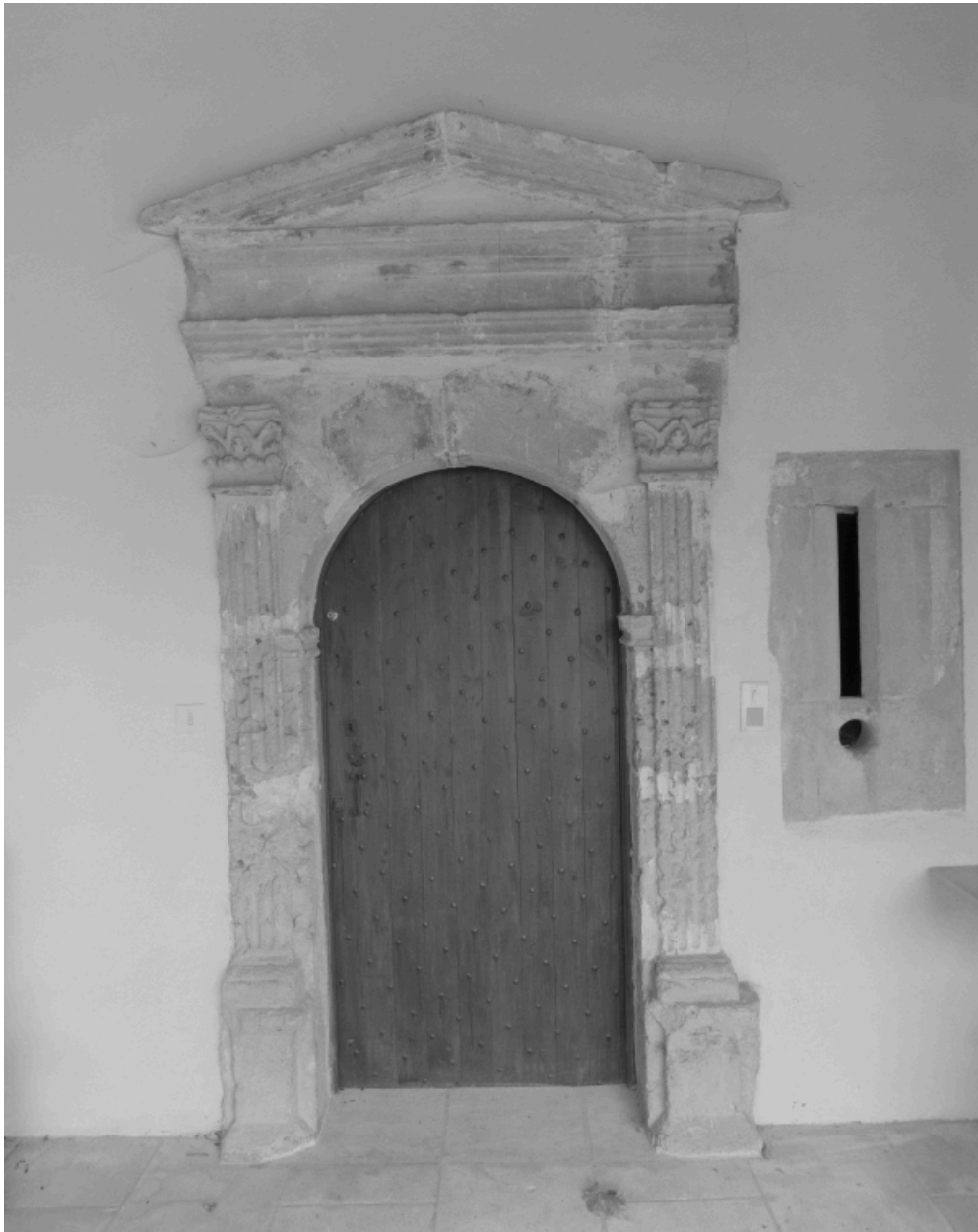
Porte d'entrée sous la galerie.
