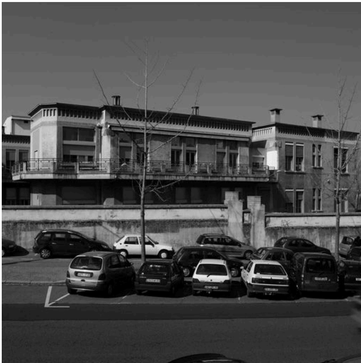
Le pavillon T Tbis. Elévation est depuis la rue Viala
