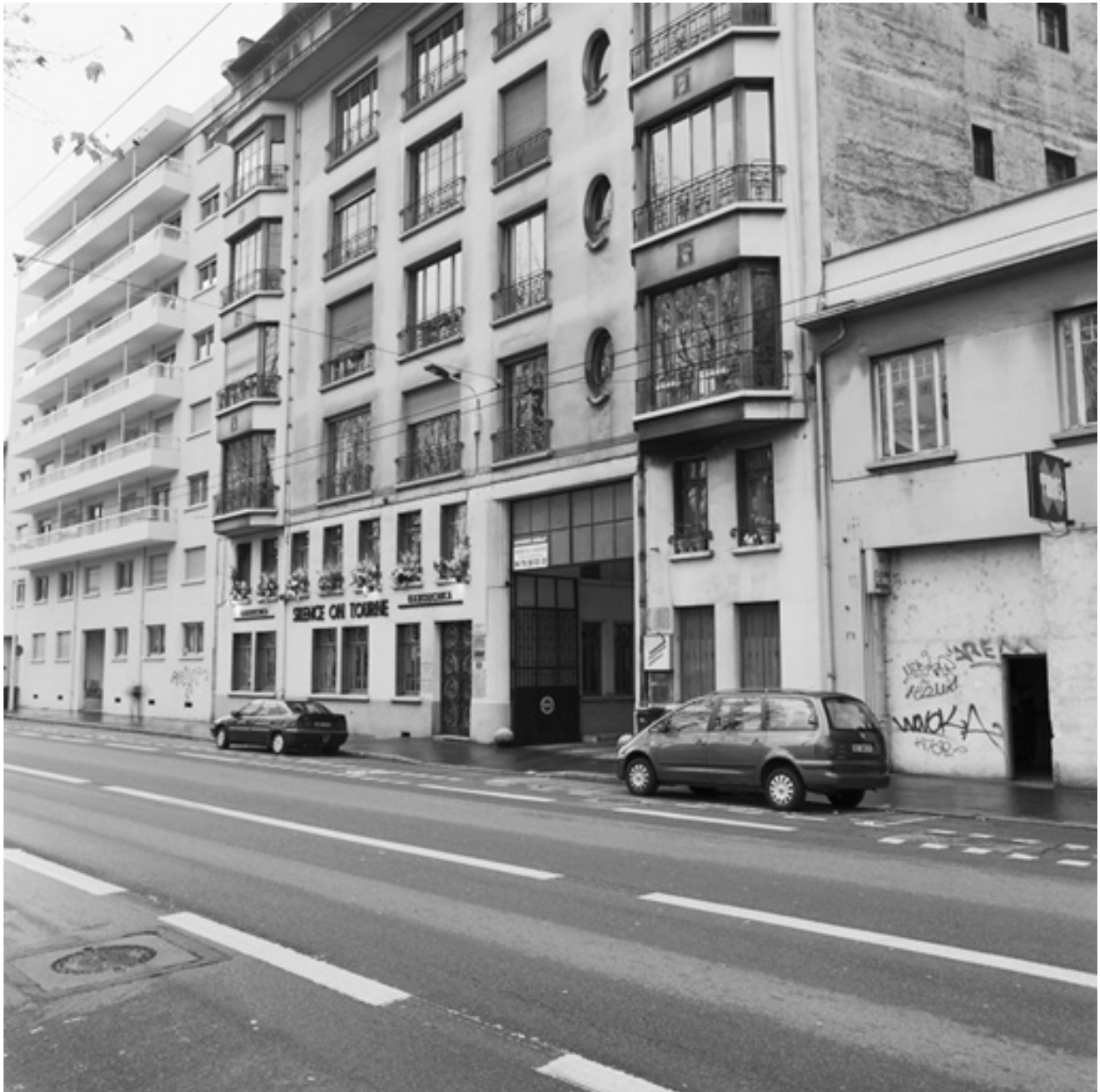
Vue d'ensemble nord-est de l'immeuble d'habitation de la famille Dousselin
