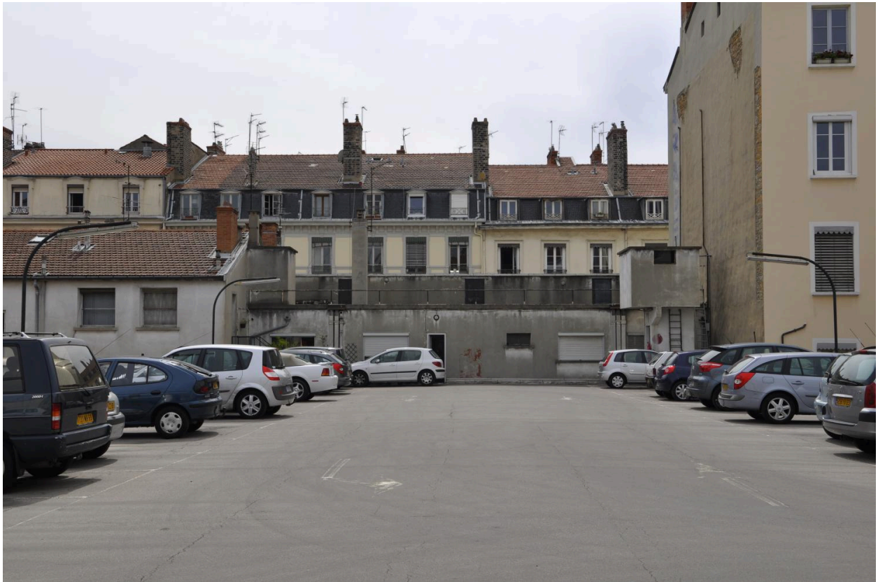
Vue panoramique du parking extérieur sur le toit du bâtiment
