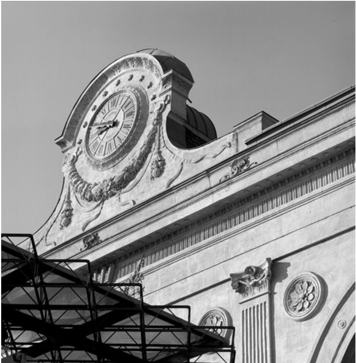
Le bâtiment-voyageurs : l'horloge, élévation nord
