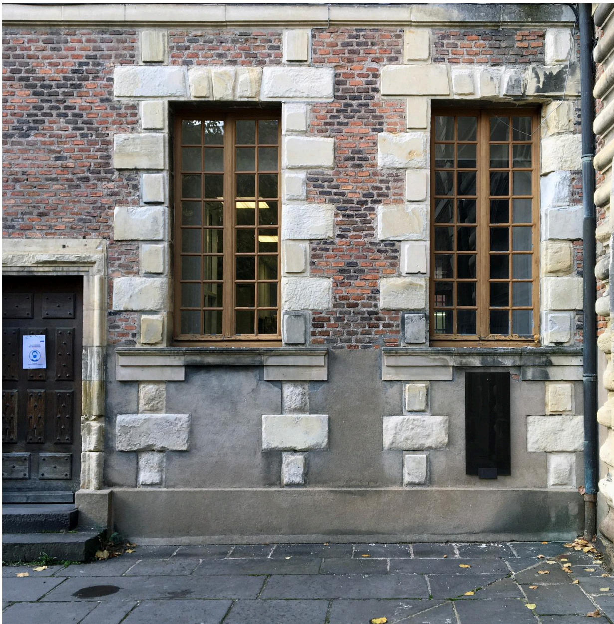
Aile nord, partie est : porte et baies des anciennes classes de 4e et 3e
