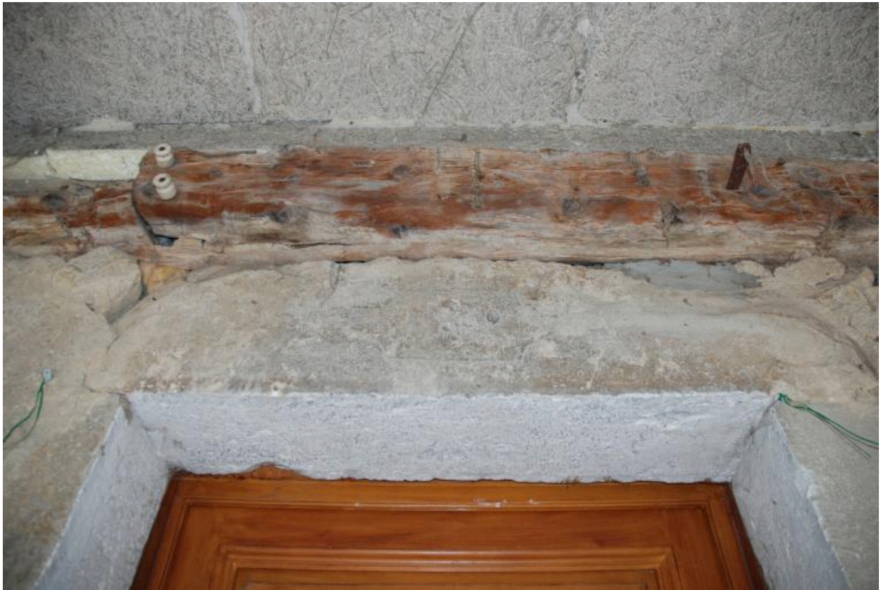
Ferme (2017 B52 1047, 2511), non repérée. Façade sur cour, détail de la date portée.
