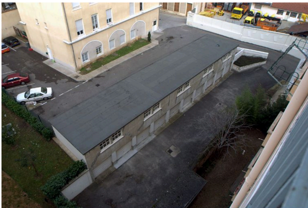
Vue générale depuis le haut
