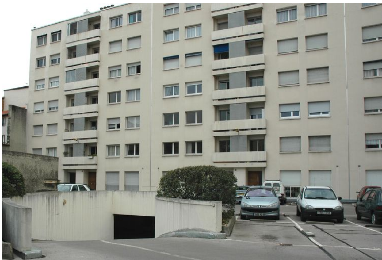
Façade postérieure du bâtiment nord, vue depuis la cour, et entrée du parking souterrain
