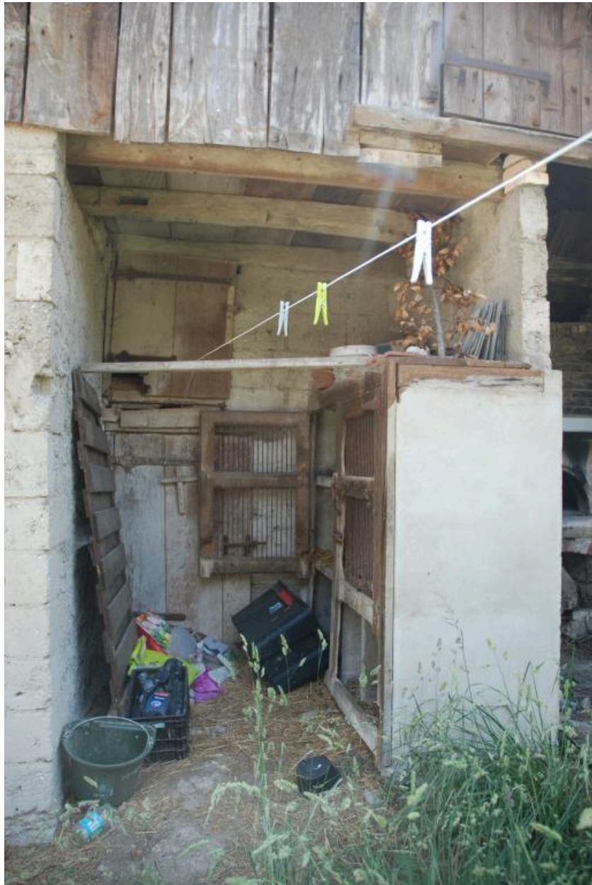
Vue du four à pain, partie gauche : clapier, loge à cochon et poulailler.
