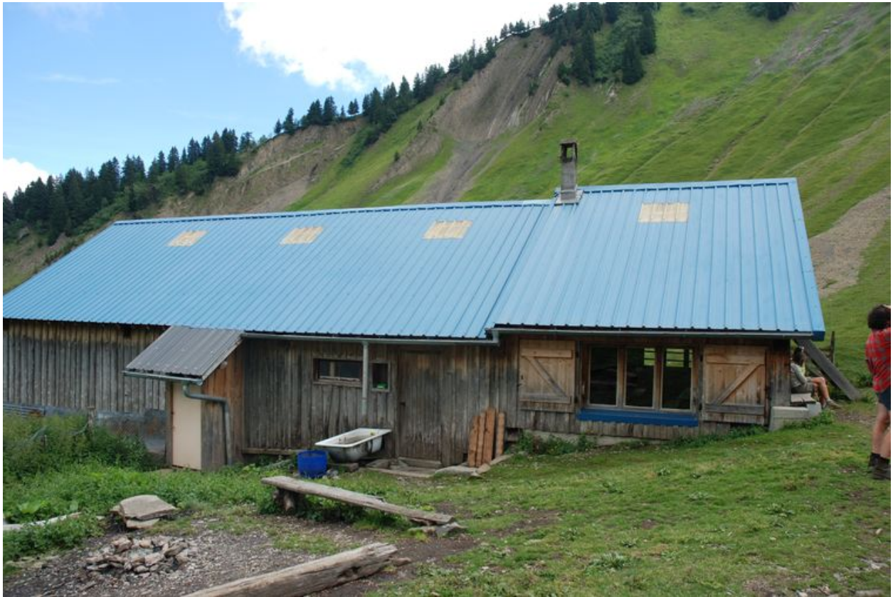
Vue de l'étable et du gîte depuis le nord.
