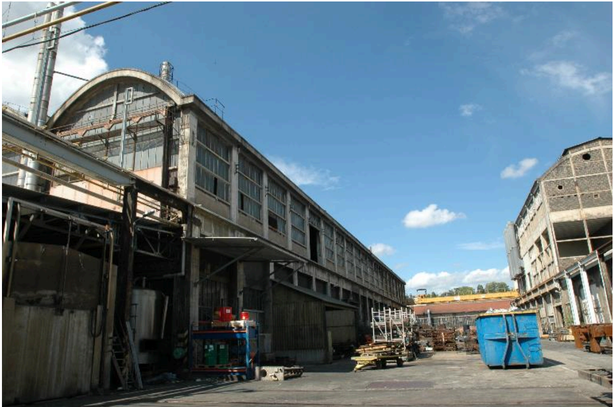
Vue extérieure des double halles
