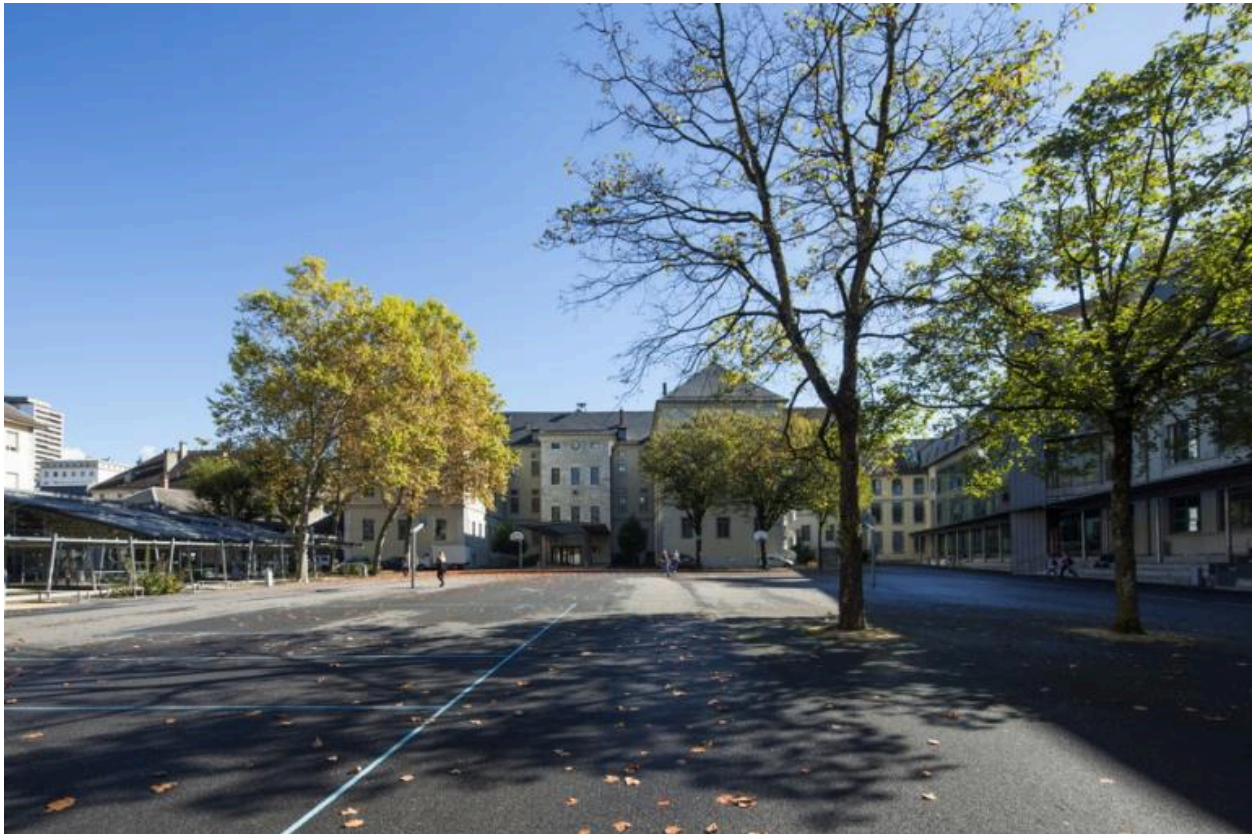
Cour intérieure, vue générale depuis le nord-ouest
