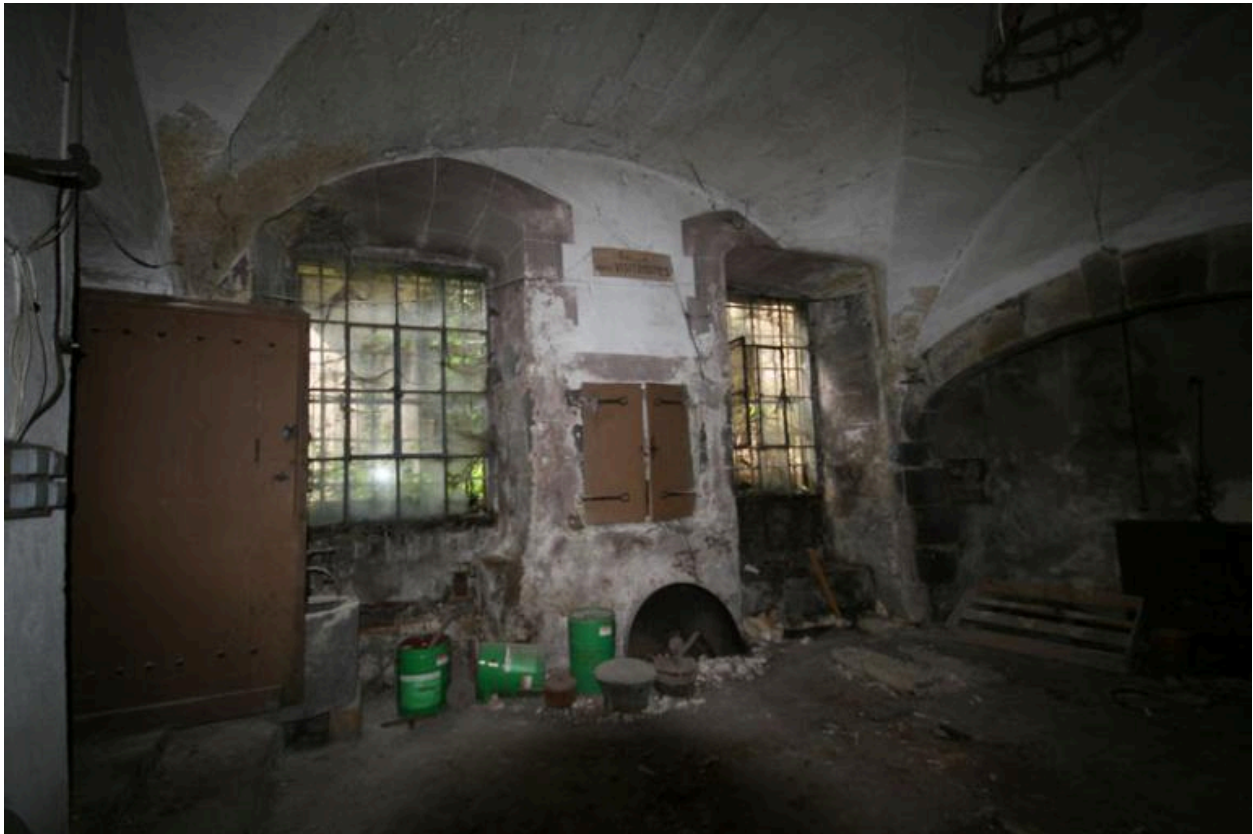
Salle du 2e étage de soubassement, dite "des Visitandines" (salle -2.1 du plan schématique) - préservée lors des travaux de 2008 (photographie chercheur).
