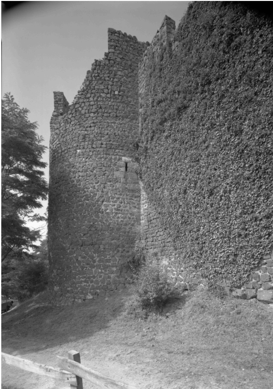
Vue extérieure de la tour nord-ouest de l'enceinte, près du portail d'entrée, depuis le sud-ouest.
