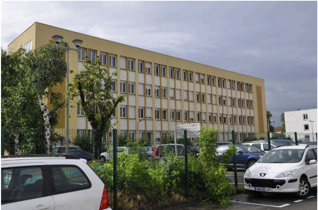
Bâtiment administratif daté des années 50.
