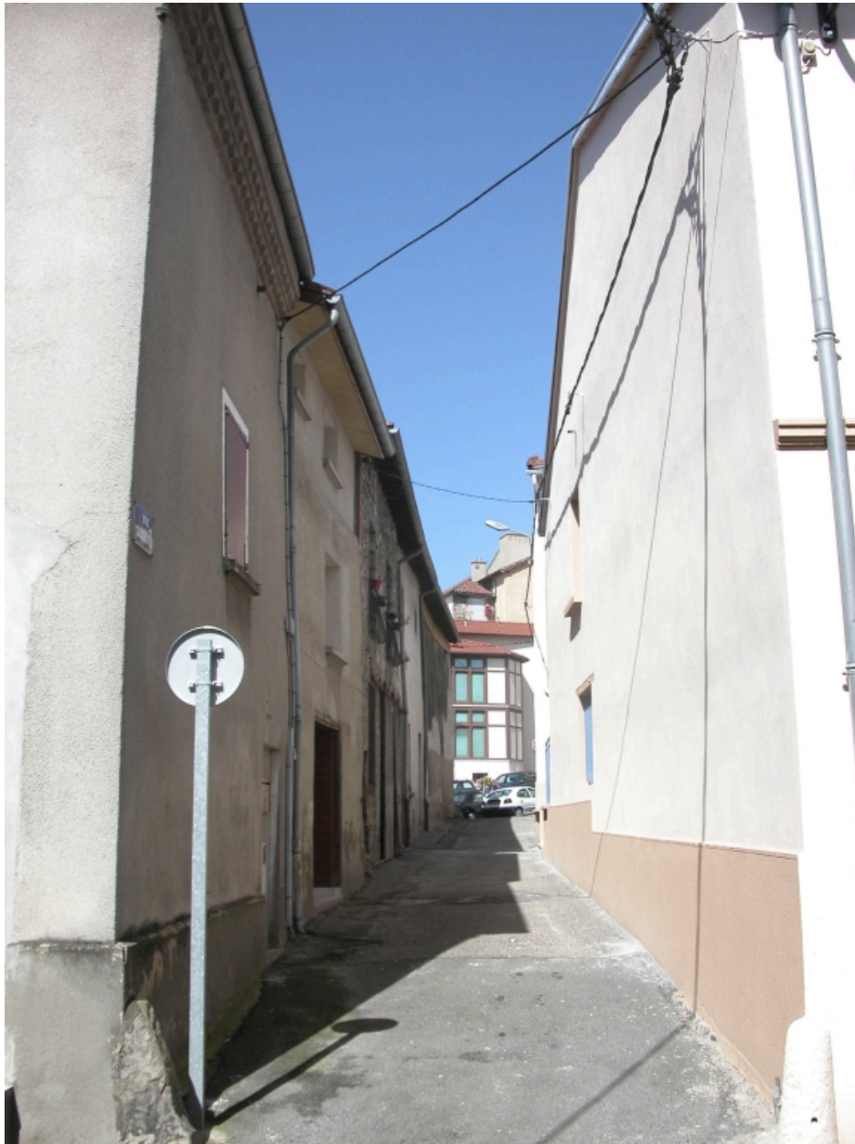
Îlot 2. Saint-Jean (rue) 38, 40. Vue générale de la traversière Saint-Jean entre les deux maisons.
