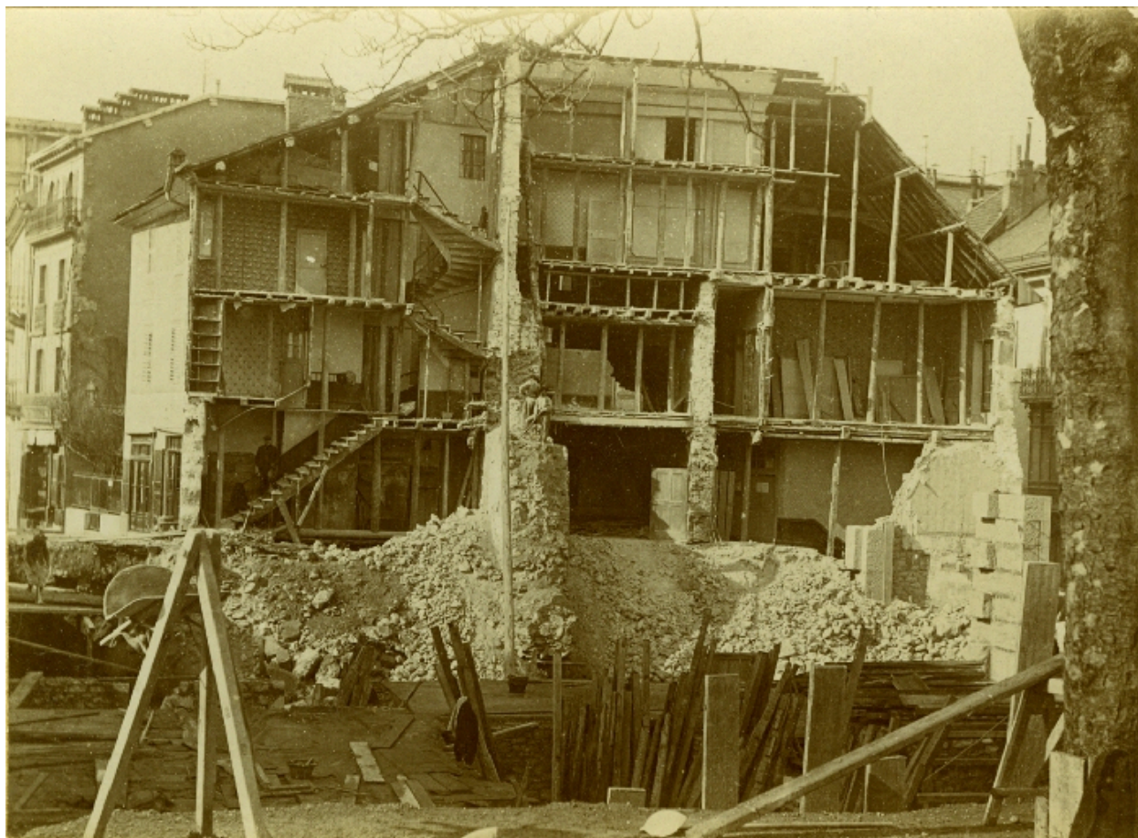
L'hôtel en cours de démolition
