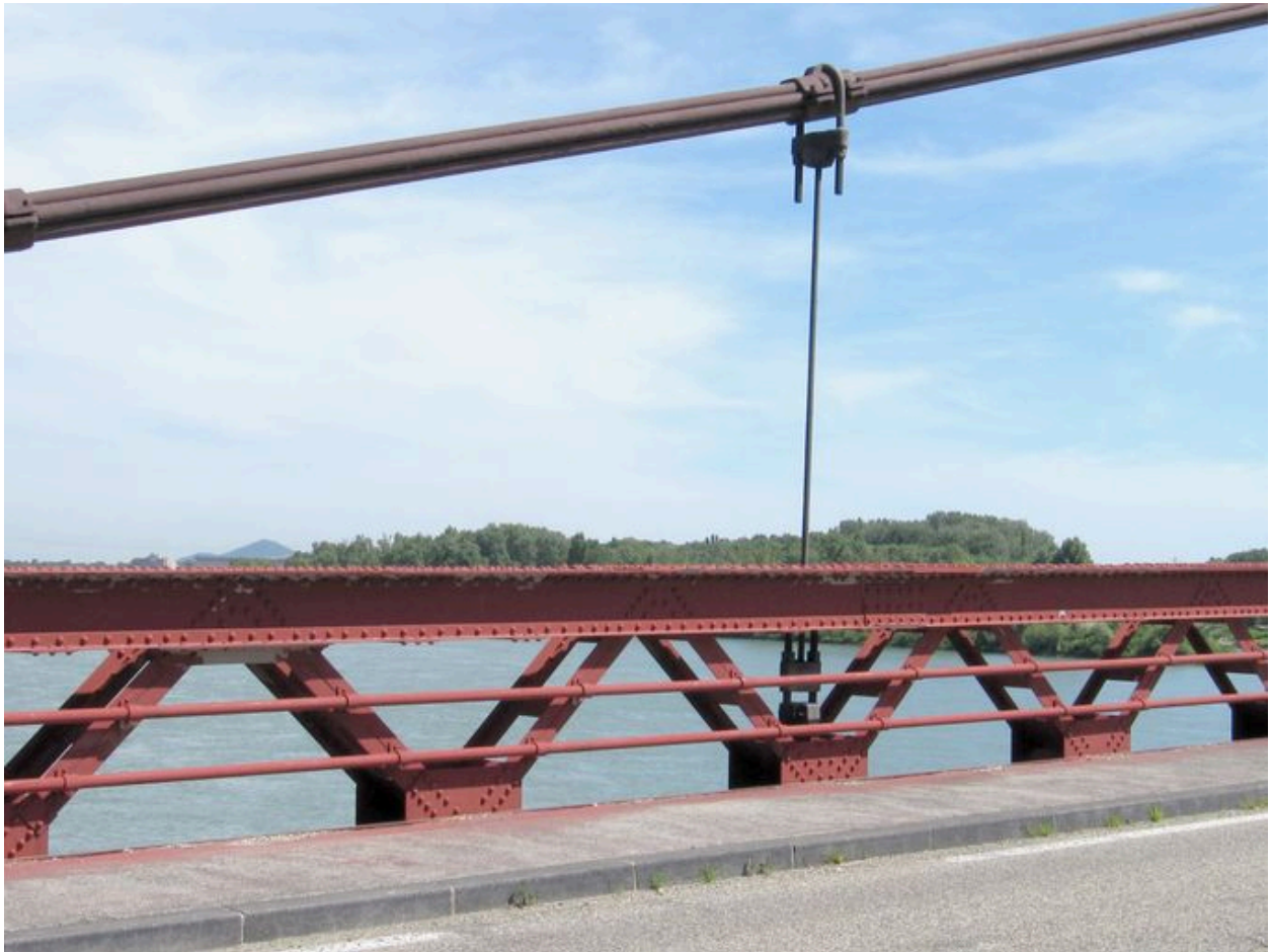
Suspente, vue générale : jonction avec le câble porteur et le tablier (depuis la rive droite)
