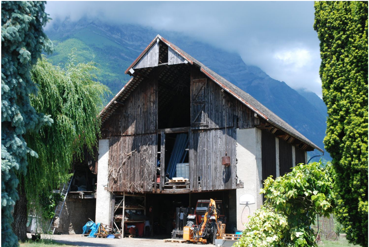
Vue du séchoir 2018 ZS 83, depuis le sud.
