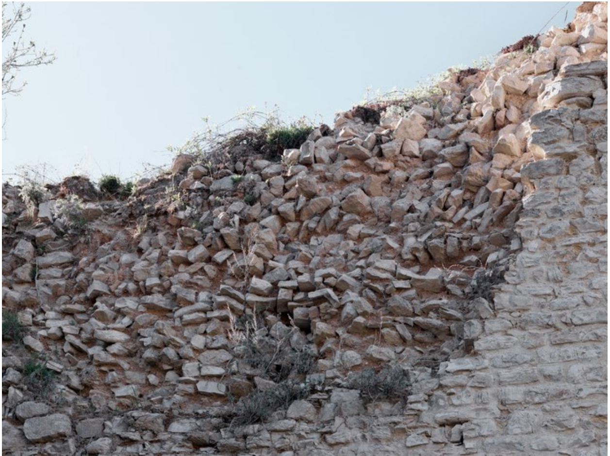
Elévation nord, fourrure de la maçonnerie.
