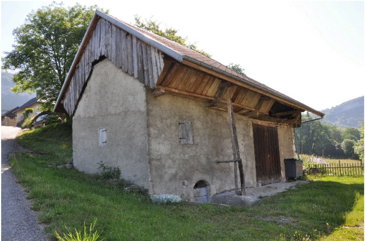
Vue générale du moulin Bizet amont, vue sud-ouest
