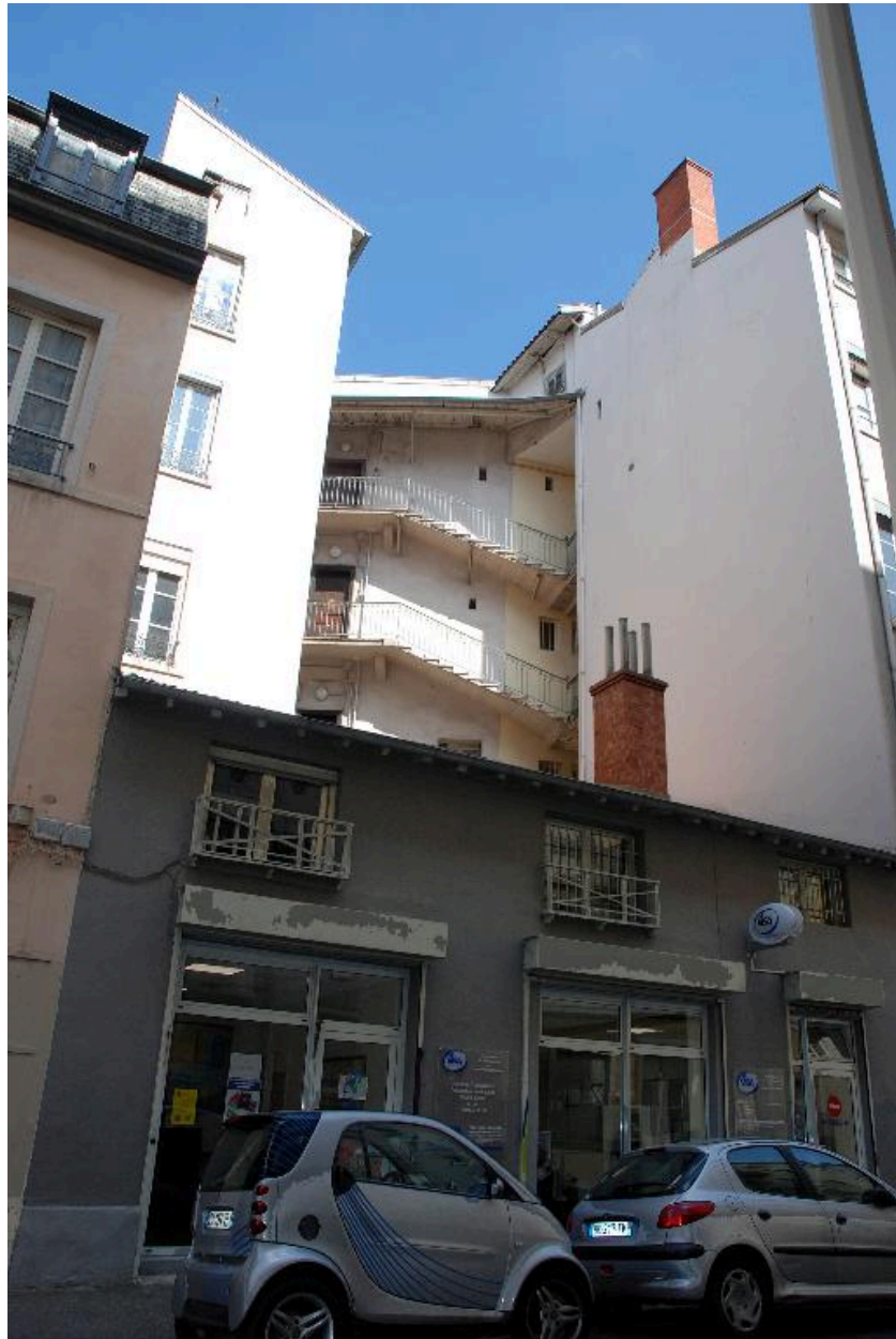
Vue d'ensemble des élévations postérieures, depuis la rue Cavenne
