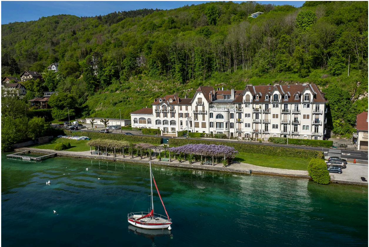
Vue d'ensemble de l'hôtel Beau-Rivage à Sevrier.
