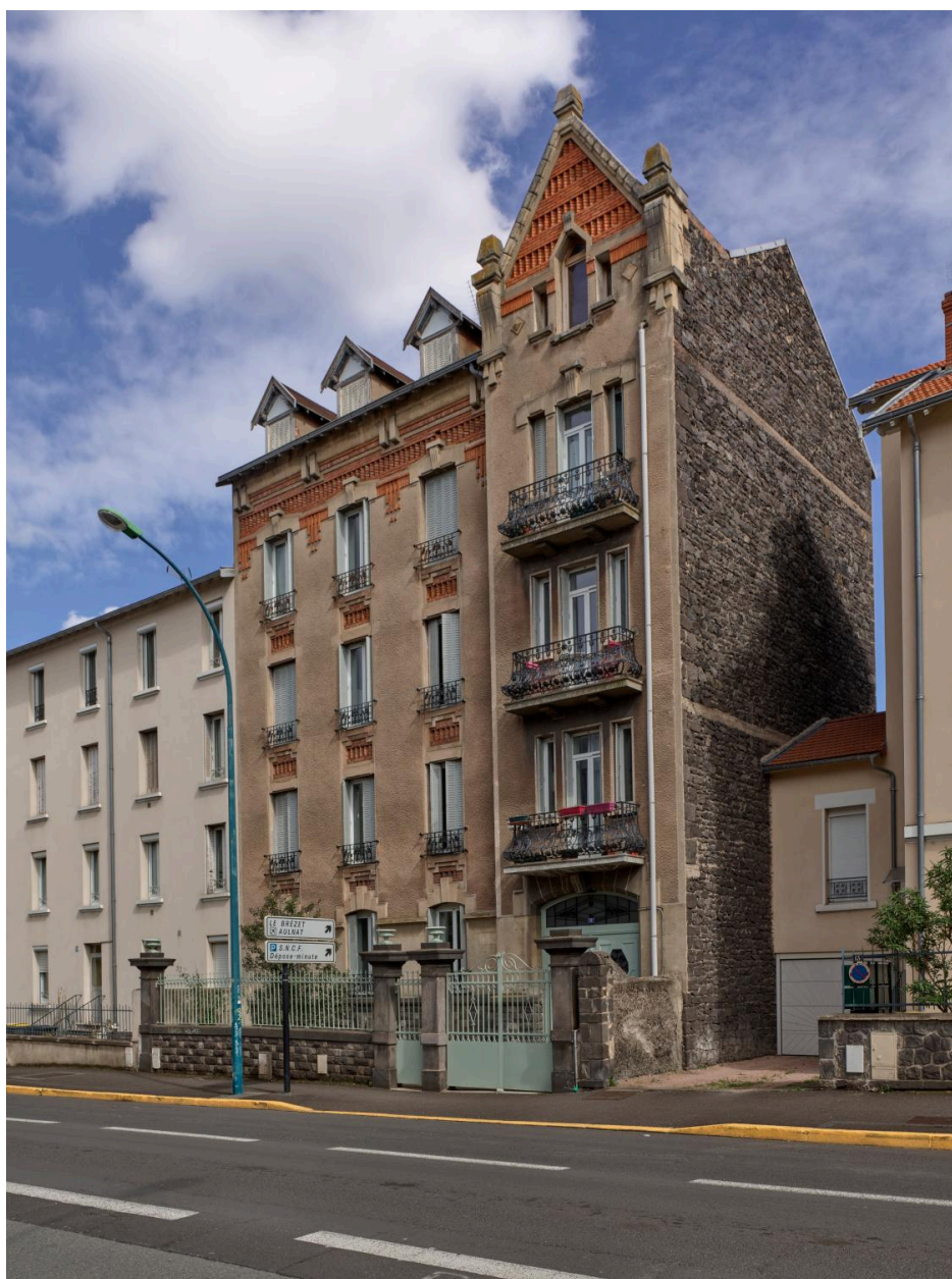
Façade du n°11 boulevard Fleury
