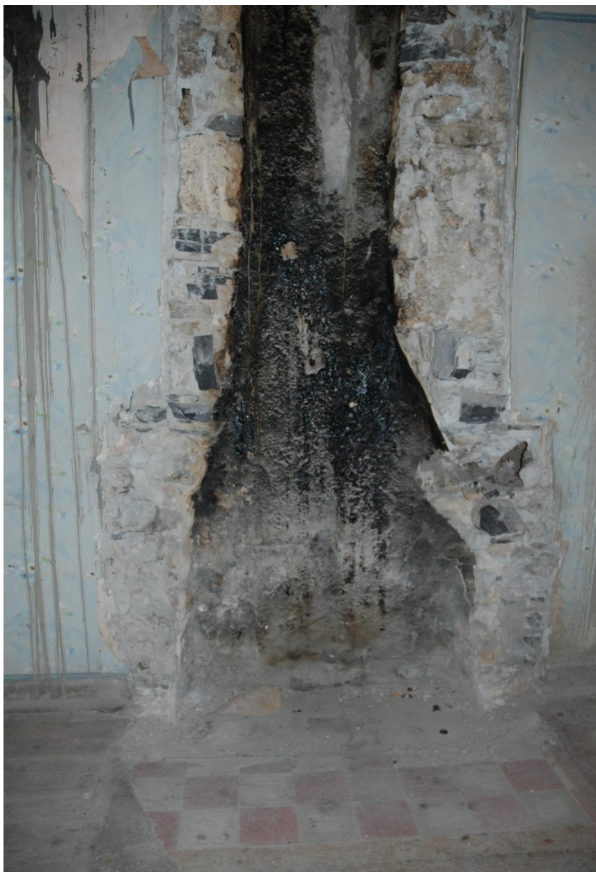
Vue intérieure du 1er étage : pièce nord, vestige de cheminée.
