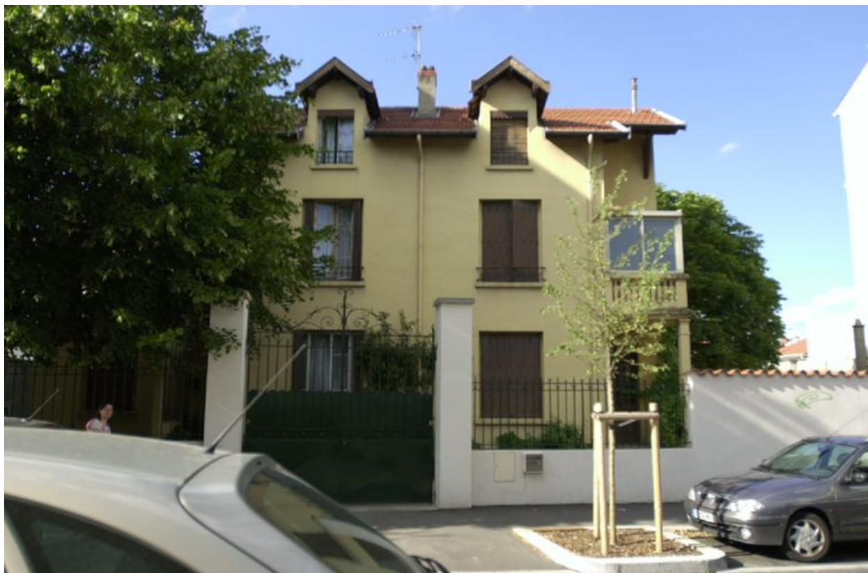
Façades vues depuis la rue
