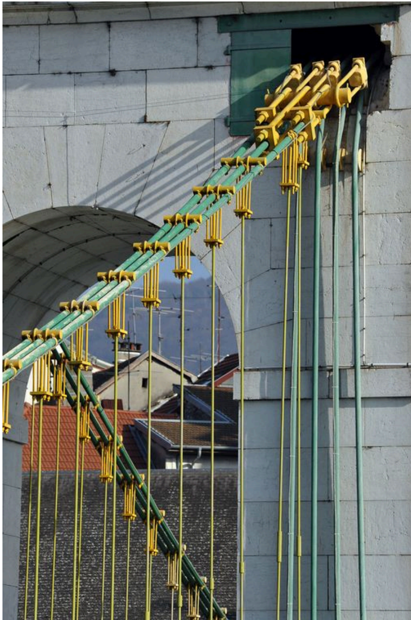
Pile centrale, vue de détail : ancrage des câbles porteurs sur l'arc monumental (depuis la rive droite)
