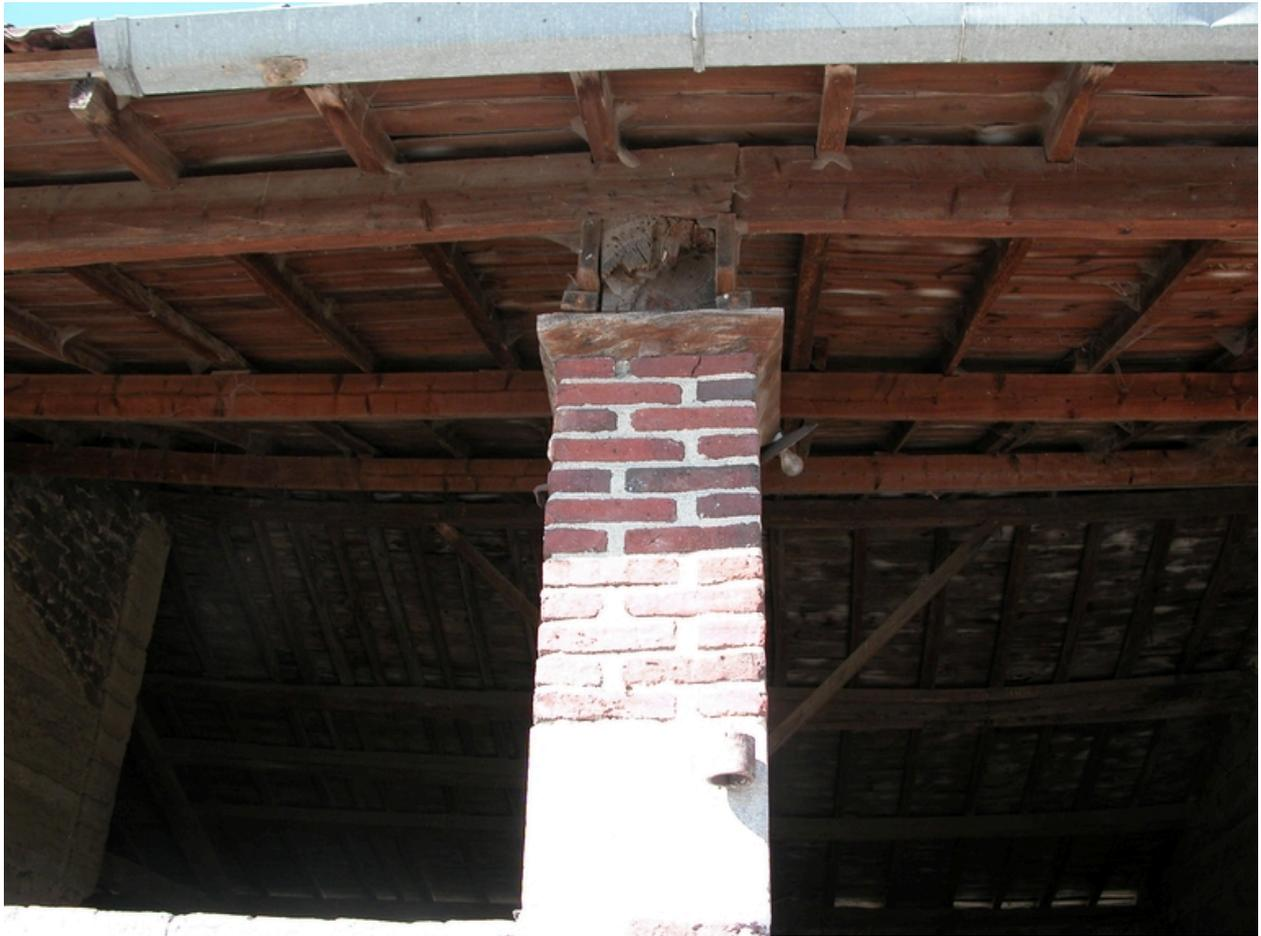
Détail d'un pilier soutenant le toit des granges-remises.
