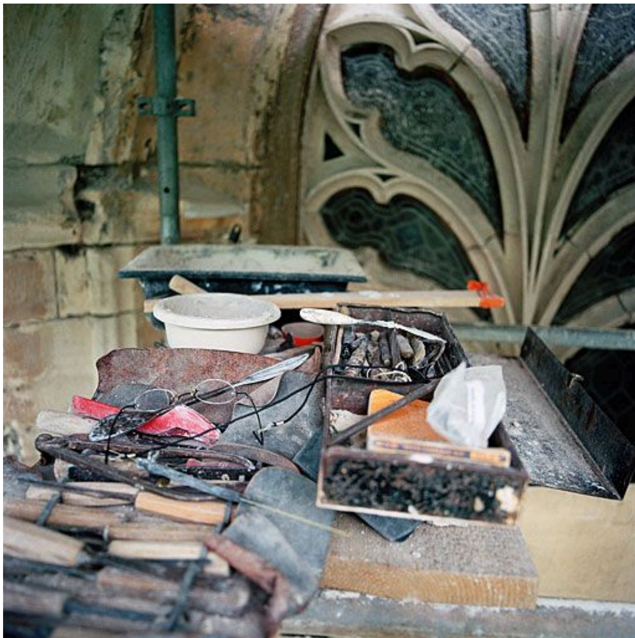
Restauration de la première chapelle nord
