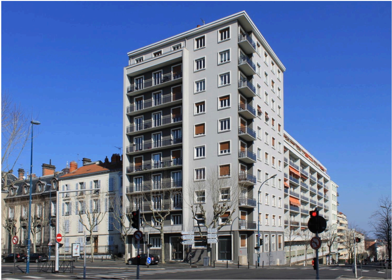
Clermont-Ferrand, angle nord-est du carrefour entre le cours Sablon et l'avenue Carnot, en face de la succursale de la Banque de France.
