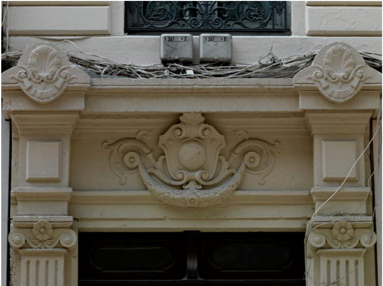
Élévation antérieure : la porte, partie supérieure
