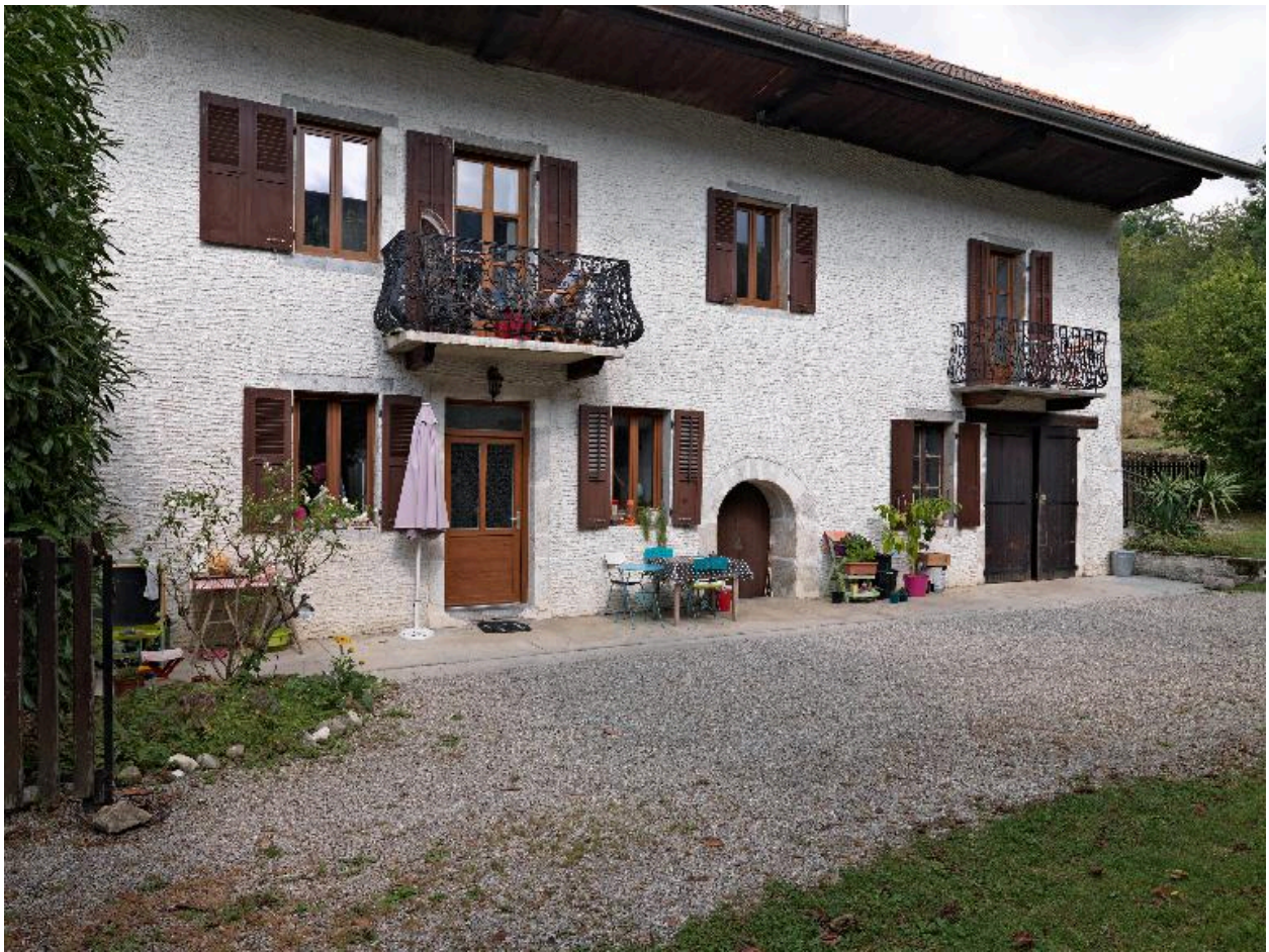
Vue d'ensemble de la façade sur cour.
