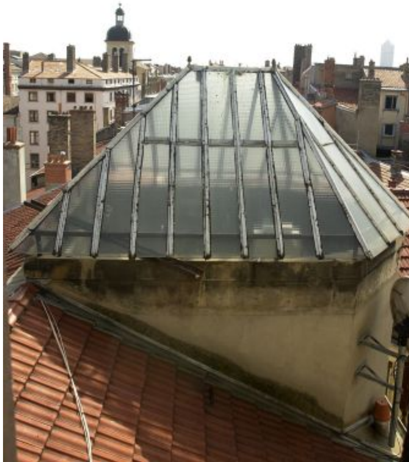
Couronnement de l'escalier
