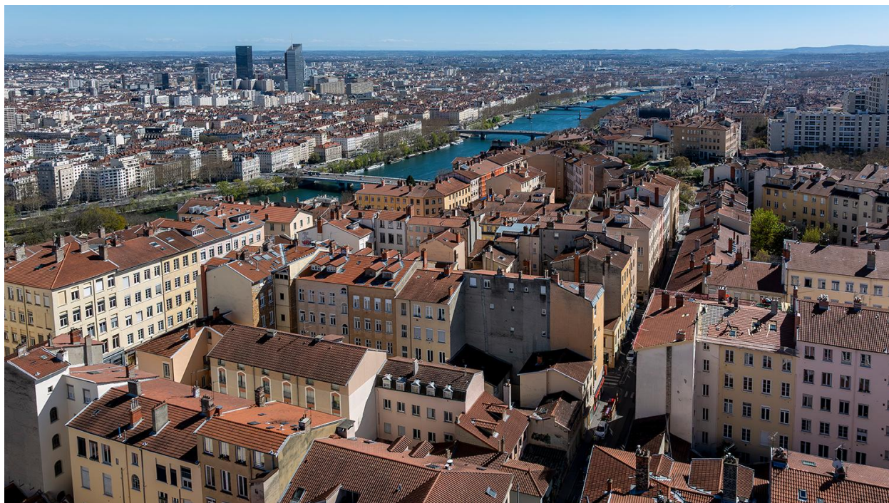
Vue d'ensemble secteur des immeubles-ateliers (vue drone)
