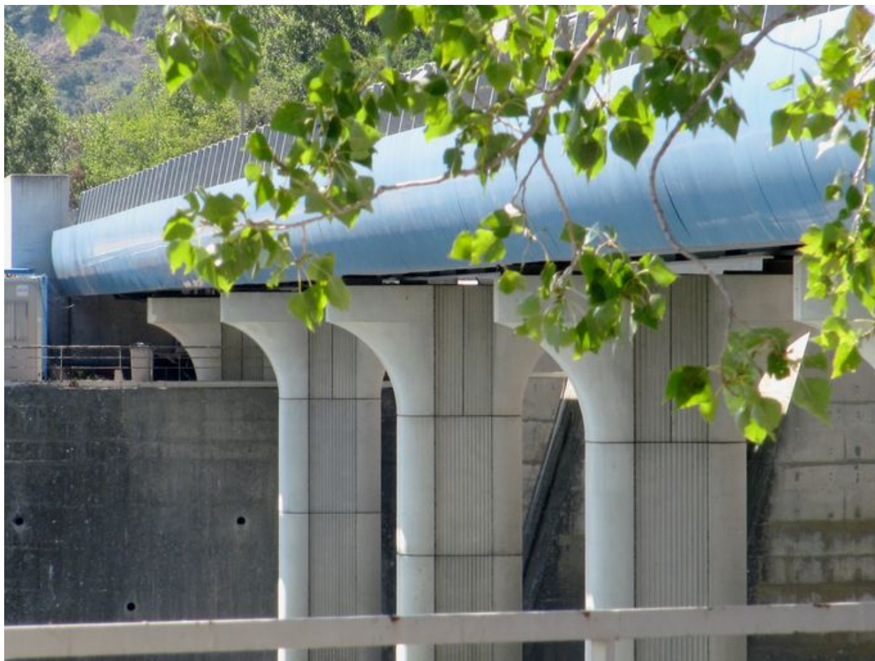
Piles du pont aval (depuis la rive gauche)
