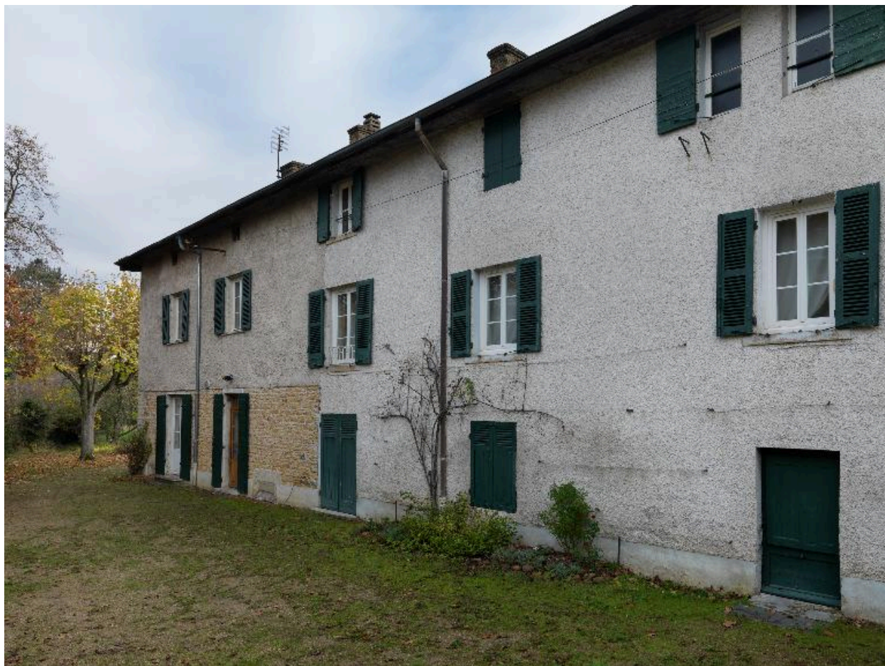
Maison de maître, élévation ouest
