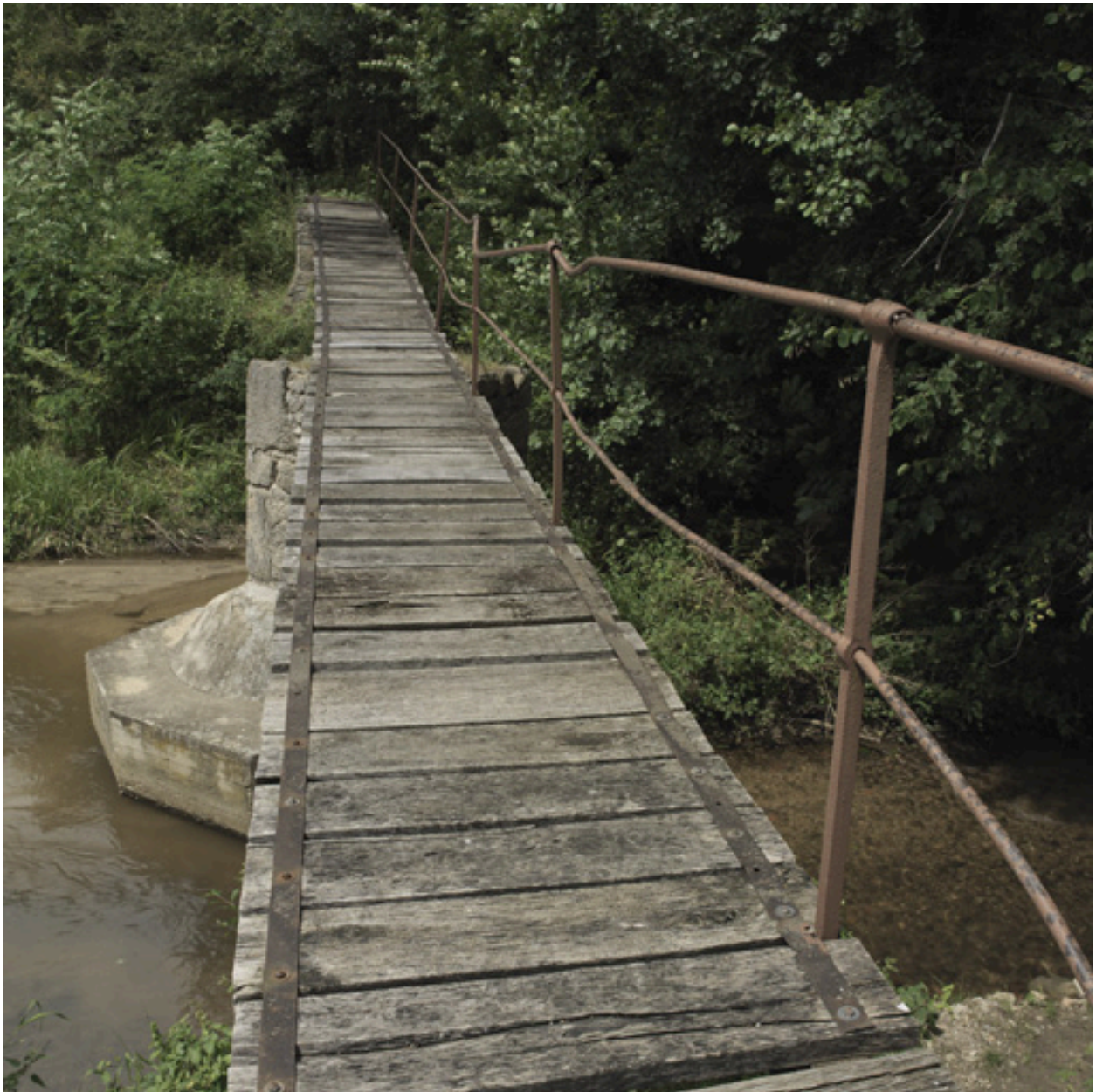
Vue d'ensemble du tablier.
