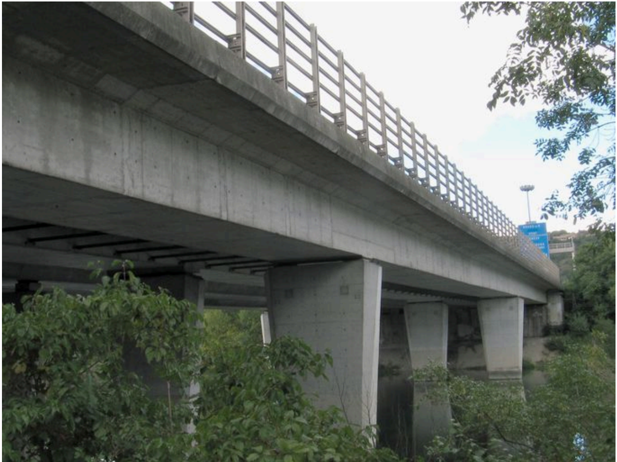
Vue latérale, face amont (depuis la rive gauche)
