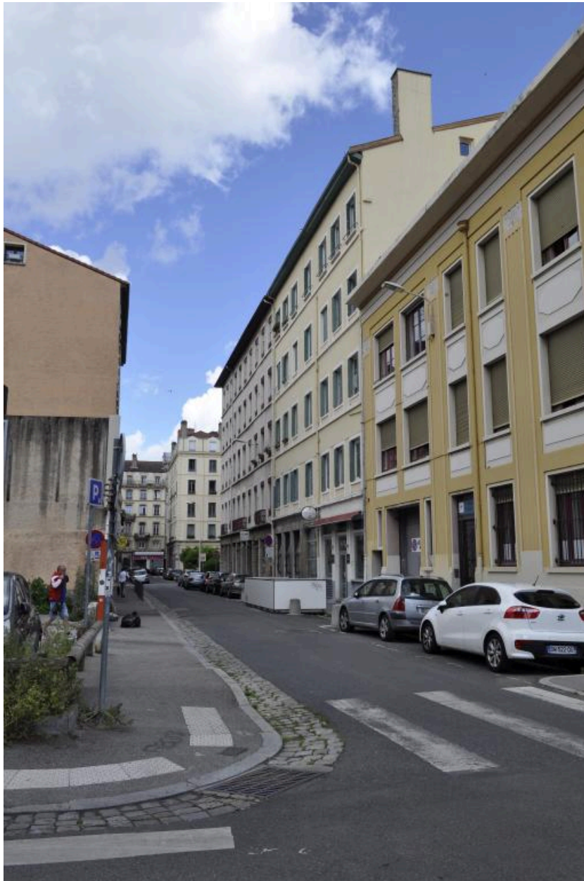
Vue de la rue Jangot depuis l'ouest, au niveau de l'espace Mazagran
