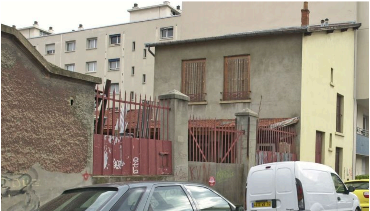
Vue du mur de clôture et de la façade sur cour depuis le sud-ouest
