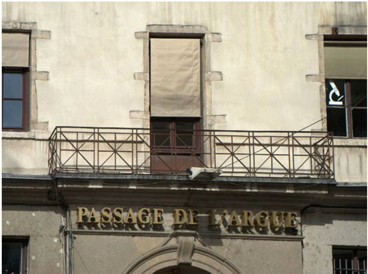
Détail du balcon surmontant l'entrée du passage de l'Argue
