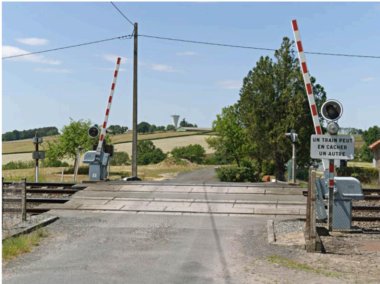
Un passage à niveau près du Bois-Duret. A l'arrière-plan, le château d'eau de Bel-Air.
