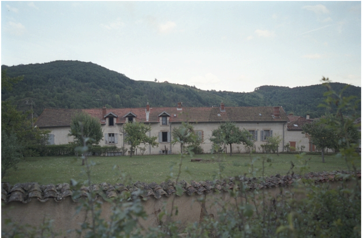
Vue d'ensemble de la façade sur rue.
