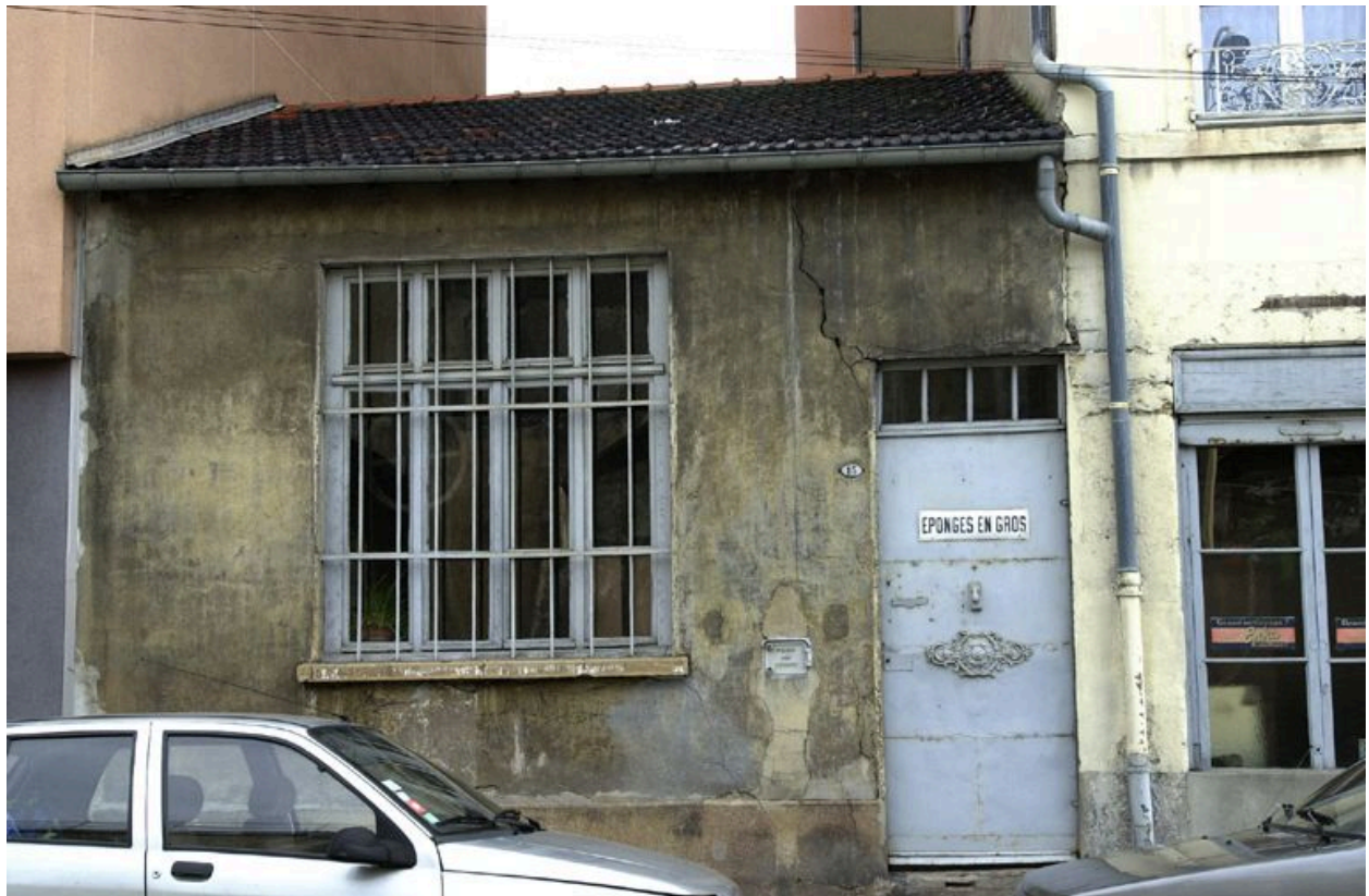
Vue de la façade ouest
