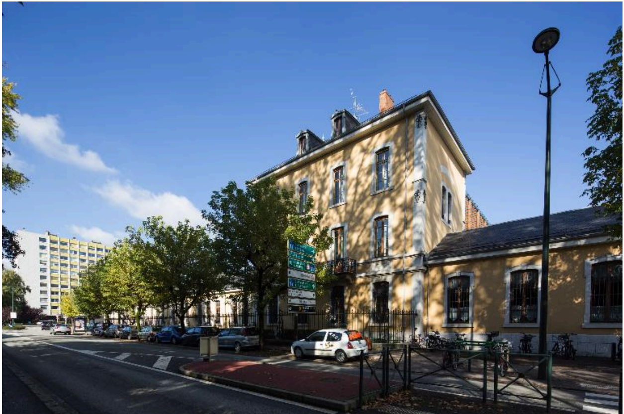
Façade boulevard du Lycée.
