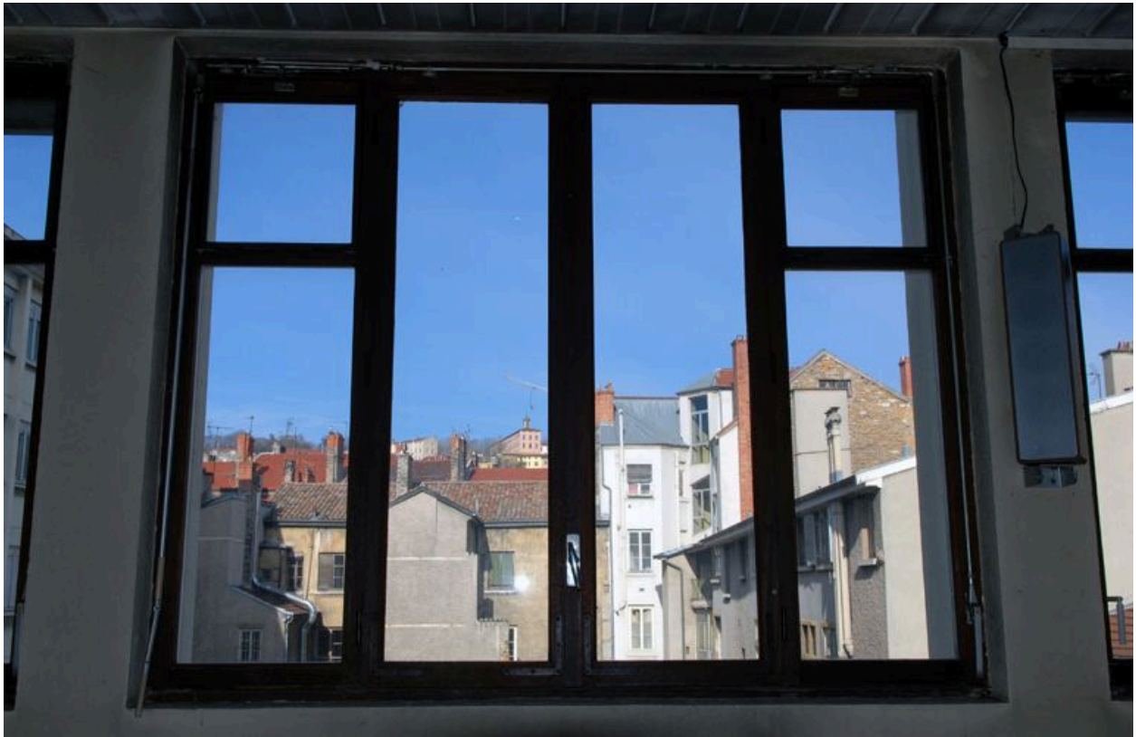
Bâtiment ISARA (2nd tranche), salle de cours, détail d'une fenêtre
